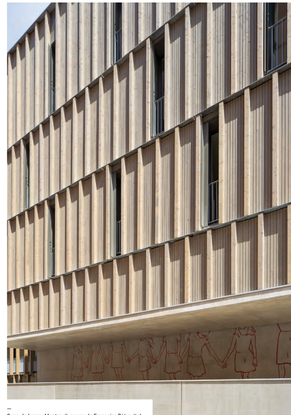
9 rue de Lagny, Montreuil, œuvre de Françoise Pétrivitch
