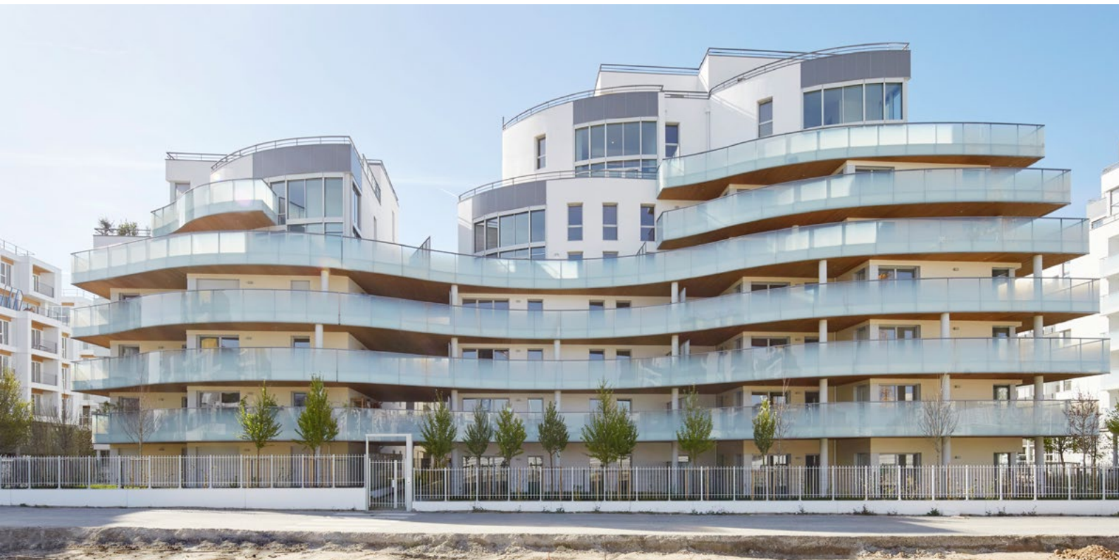
Carré de l'Arsenal, Rueil-Malmaison 92 (J. Léon) NF Habitat HQE excellent, E+ C-, Effinergie +, RT 2012 -20%.
