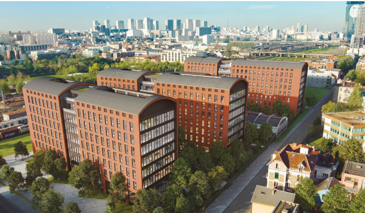
Ivry Confluences, Acte VII - rue Molière, Ivry-sur-Seine, 94 (Nineteen)
